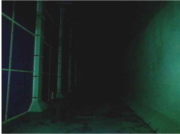
<배수지 1지 전경>
