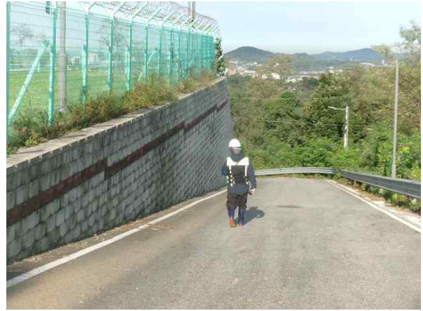
<외부 개별부재 외관조사>
