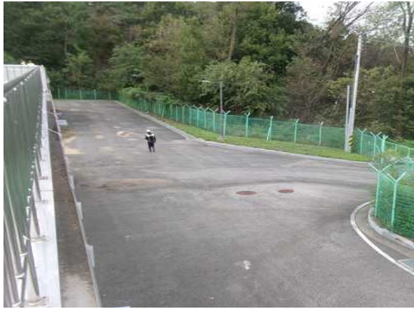
<외부 개별부재 외관조사>
