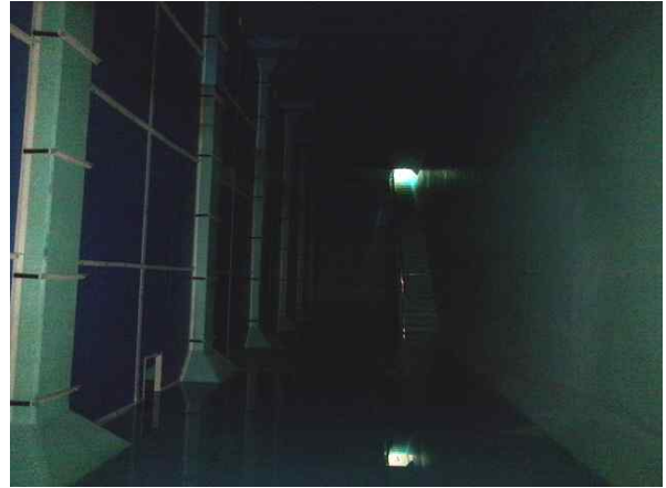
<배수지 2지 전경>
